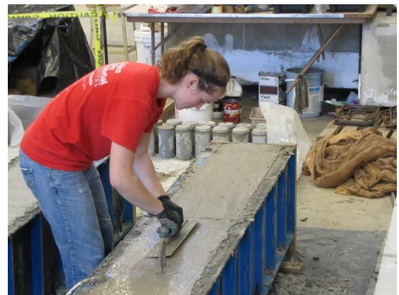
(d) Concrete finishing
